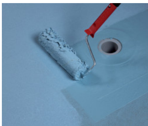
Нанесение валиком второго слоя Mapelastic AquaDefense
