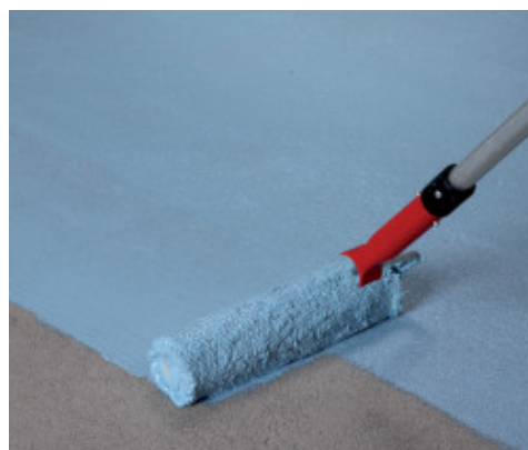
Нанесение первого слоя Mapelastic AquaDefense на стяжку
