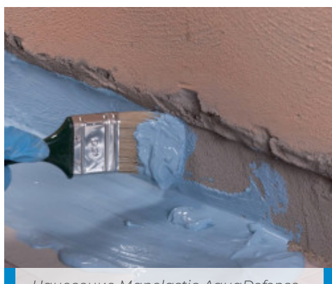
Нанесение Mapelastic AquaDefense кистью на стык между полом и стеной перед укладкой Mapeband
