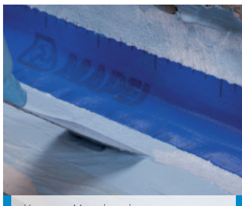
Укладка Mapeband на стык между полом и стеной с помощью Mapelastic AquaDefense
