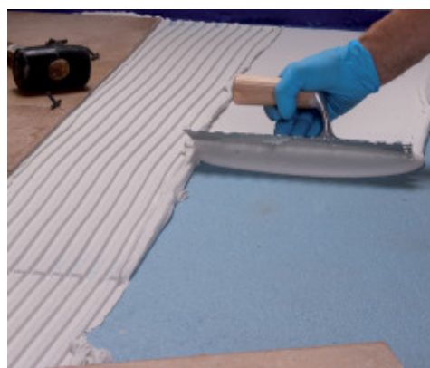
Приклеивание плитки на Mapelastic AquaDefense
