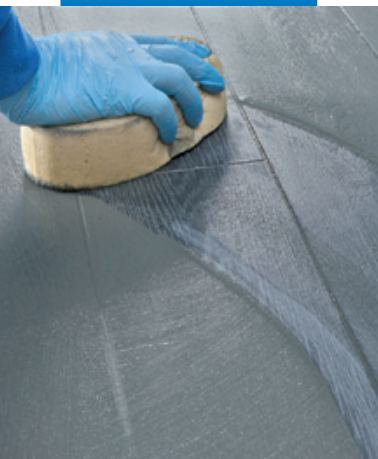
Окончательная очистка плитки с помощью целлюлозной губки
