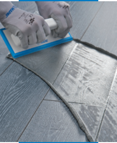
Нанесение Ultracolor Plus резиновым шпателем на пол из керамогранита с эффектом дерева
